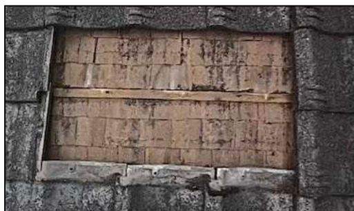
下葺防水：木羽に経年変化が見られる
