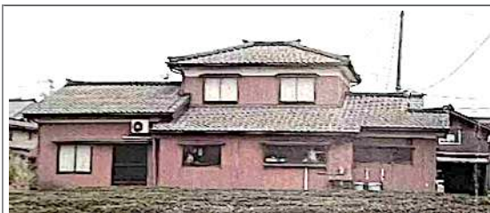
全体的に経年劣化が見られる
