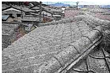
塗装が剥がれ瓦の表面の劣化が始まっている
