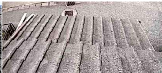
塗装が剥がれ瓦の表面の劣化が始まっている
